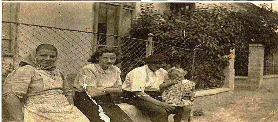
(Nahoře vlevo) bývalá hospoda U Hrončíků, naproti je vidět číslo 29 -kovárna a kdysi také hospoda. (Dolní foto) před hospodou U Hrončíků bývala i malá předzahrádka, vchod byl ze silnice, později byl ale zazděn a nahrazen dalším oknem. Všechny tři staré šenky byly téměř vedle sebe. (Fotografie vpravo nahoře) původní číslo 23, v roce 1876 prodány 2/3 chalupy a vznikají čísla 23 a 32, hospoda zaniká. foto archiv
